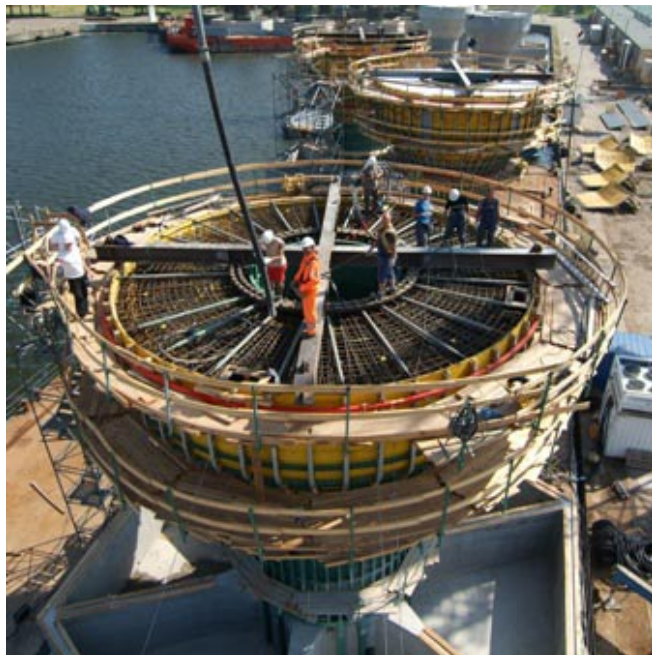
Fot. 8. Betonowanie kielicha
