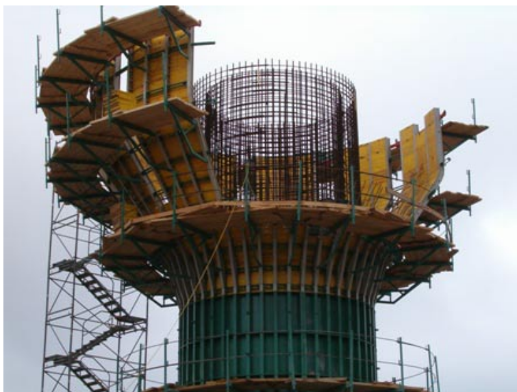
Fot. 7. Przygotowanie szalowania kielichów
