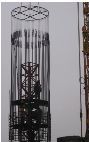
Fot. 5. Prace zbrojarskie
