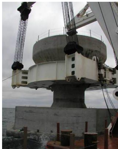
Fot. 10. Posadowienie fundamentu w morzu
