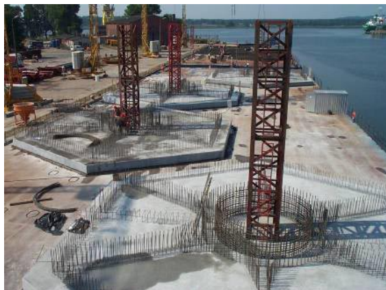
Fot. 6. Stopy fundamentów
