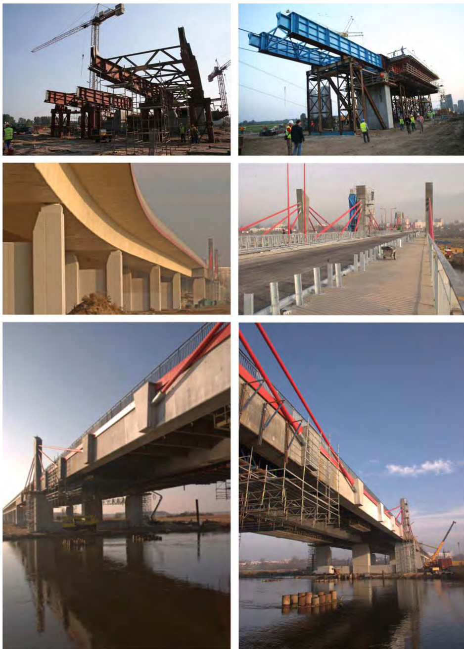
Fot. 5. Budowa betonowego mostu przez Wartę w ciągu obwodnicy Konina (2007)
