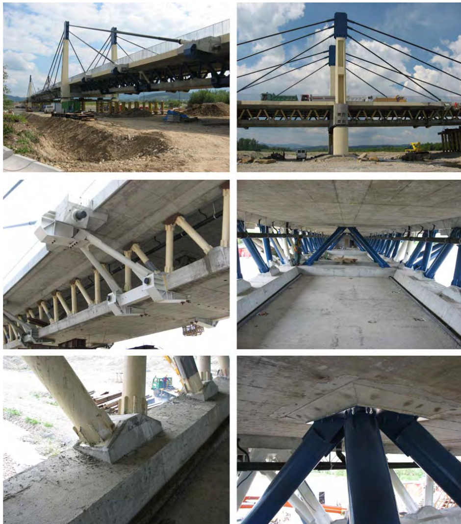
Fot. 6. Most podwieszony (podwójnie zespolony) nad Dunajcem w ciągu obwodnicy Starego Sącza (2008)
