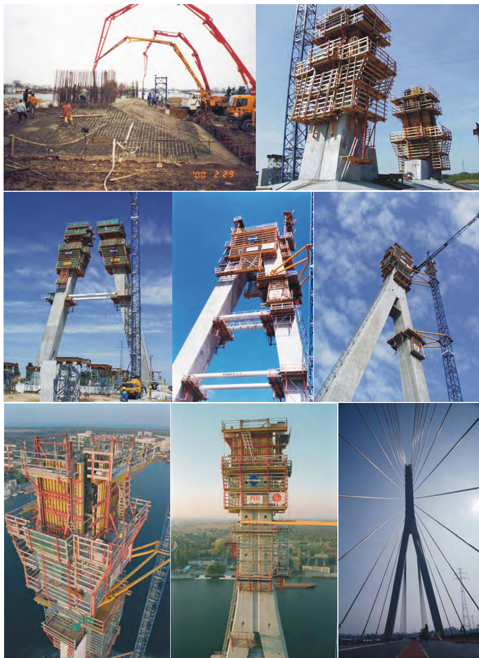
Fot. 14. Poszczególne fazy budowy pylonu mostu III Tysiąclecia im. Jana Pawła II w Gdańsku
