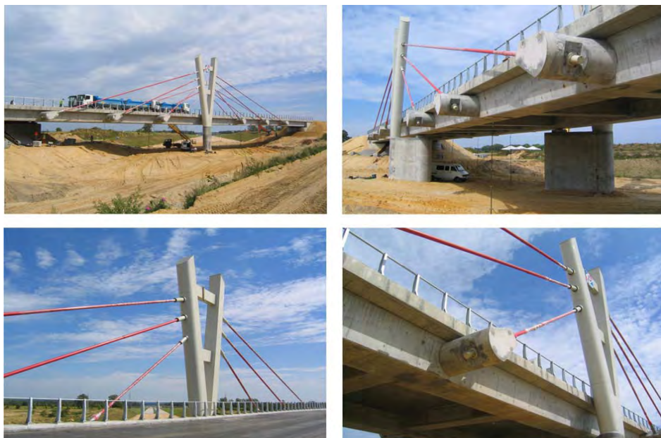
Fot. 7. Wiadukt w ciągu drogi 94 nad autostradą A4 w Wykrotach (2008)
