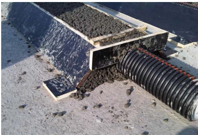
Fot. 9. Beton o otwartej strukturze w systemie drenażowym tunelu
