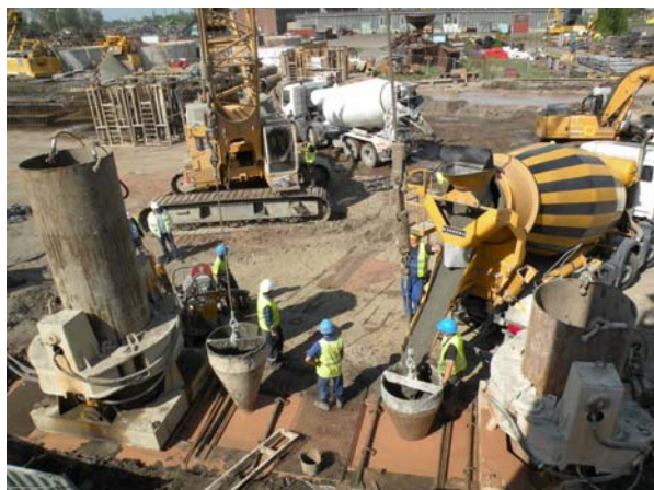
Fot. 1. Betonowanie sekcji ściany szczelinowej
