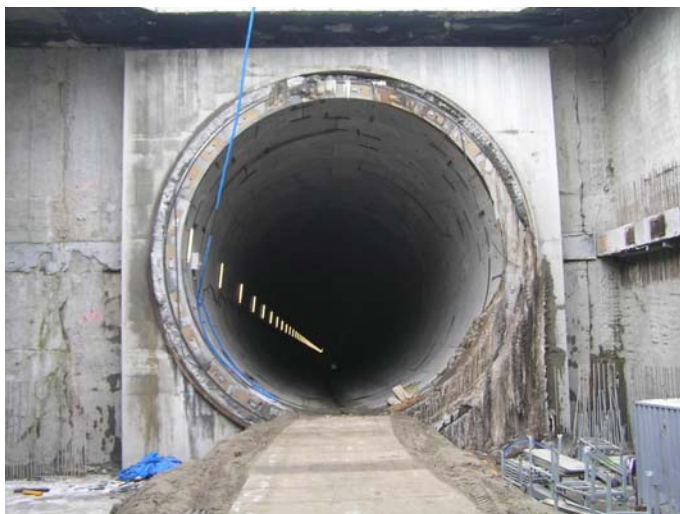
Fot. 5. Widok ściany okularowej w szybie startowym
