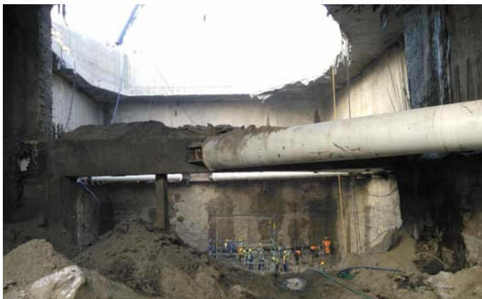
Fot. 2. Ściany szczelinowe w obrębie komory startowej TBM
