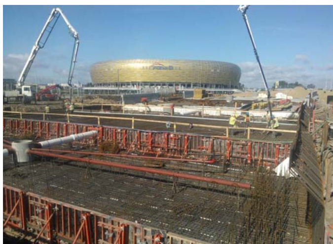
Fot. 3. Betonowanie płyty fundamentowej wanny żelbetowej
