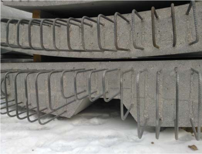
Fot. 8. Przestrzeń drenażowa w spodnim prefabrykacie konstrukcji jezdni
