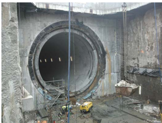
Fot. 7. Widok ściany okularowej w szybie wyjściowym
