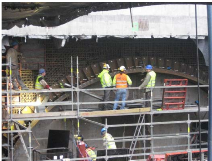
Fot. 6. Widok zbrojenia ściany okularowej szybu wyjściowego
