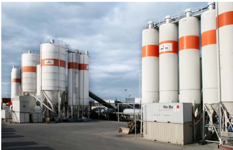
Fot. 5. W szczytowych okresach betoniarnie dysponowały 6 węzłami
