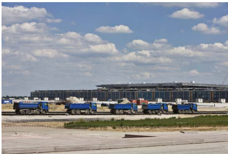
Fot. 11. W każdej minucie zakład opuszczają ciężarówki i betonowozy
