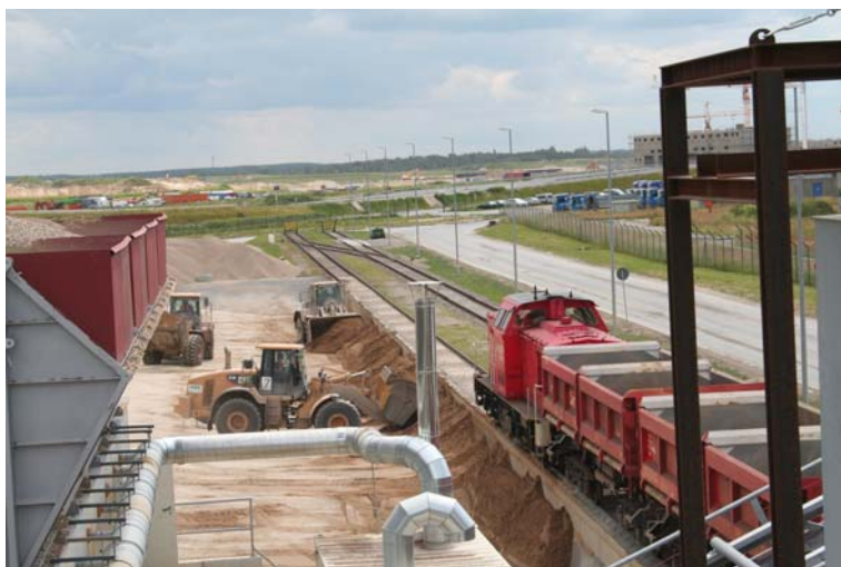
Fot. 7. Do betoniarni trafiało codziennie do sześciu pociągów z kruszywem
