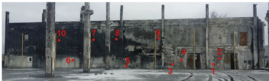
Fot. 3. Lokalizacja miejsc pobrania próbek rdzeniowych betonu
