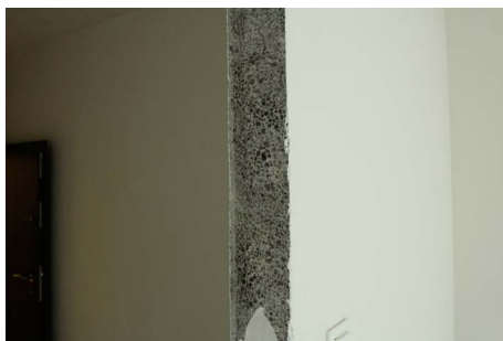
Fot. 16. Przekrój ściany keramzytowej
