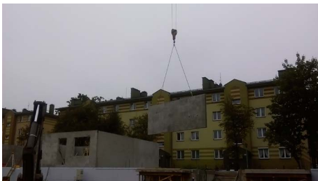
Fot. 12. Wznoszenie klatki nr 1
