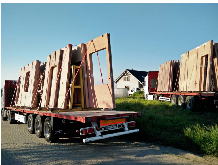
Fot. 2. Sposób transportu prefabrykowanych ścian keramzytobetonowych
