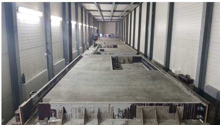
Fot. 1. Produkcja ścian w zakładzie prefabrykacji
