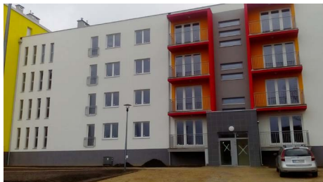
Fot. 11. Wznoszenie klatki nr 3
