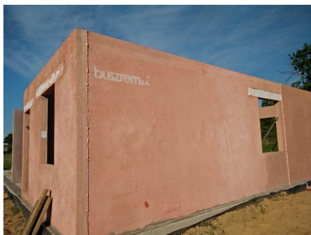
Fot. 6. Elementy zamontowane
