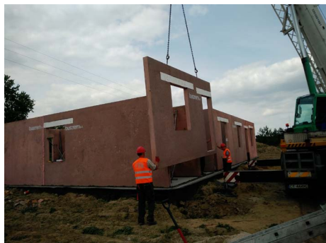
Fot. 3. Rozładunek ścian
