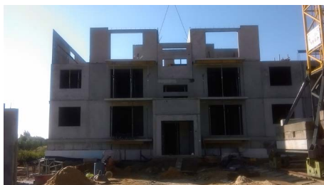
Fot. 8. Montaż ścian
