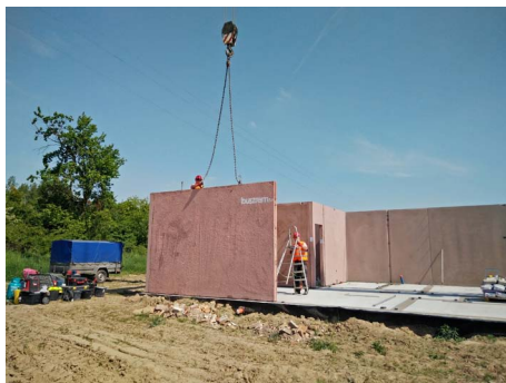
Fot. 4. Ustawianie ścian na budowie
