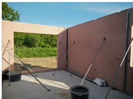
Fot. 5. Montaż ścian
