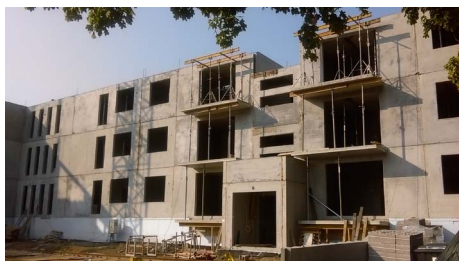
Fot. 9. Układ zamontowanych ścian
