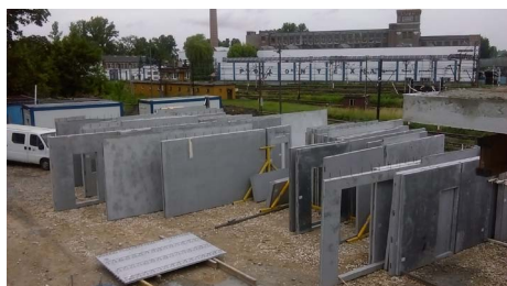
Fot. 7. Rozładunek ścian
