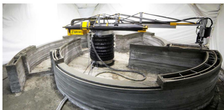
Fot. 1. Proces drukowania betonu [9].
