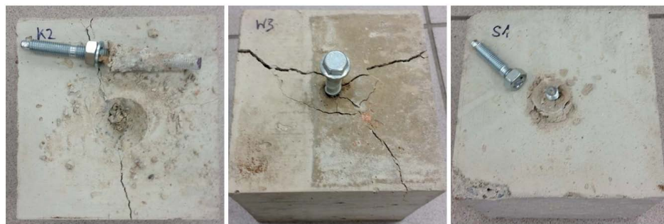
Fot. 2. Modele zniszczenia (od lewej): wyciągnięcie kotwy, rozłupanie betonu oraz zniszczenie stali kotwy
