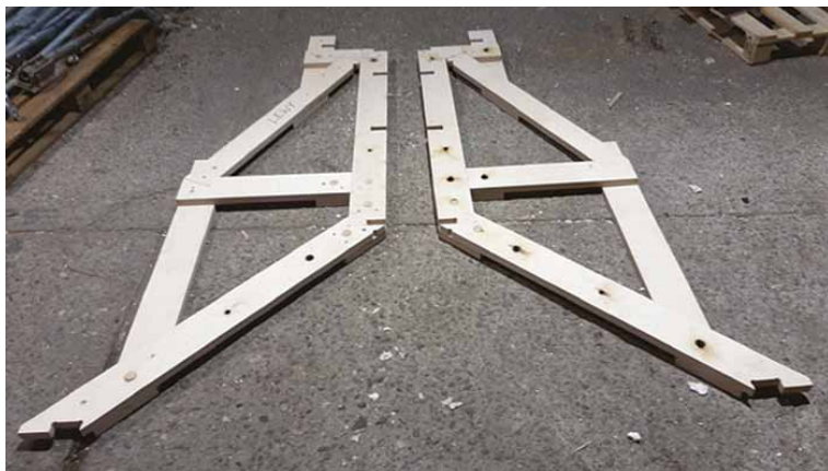
Rys.15 Dwie kosane kratownice zewnętrzne etapu 2
