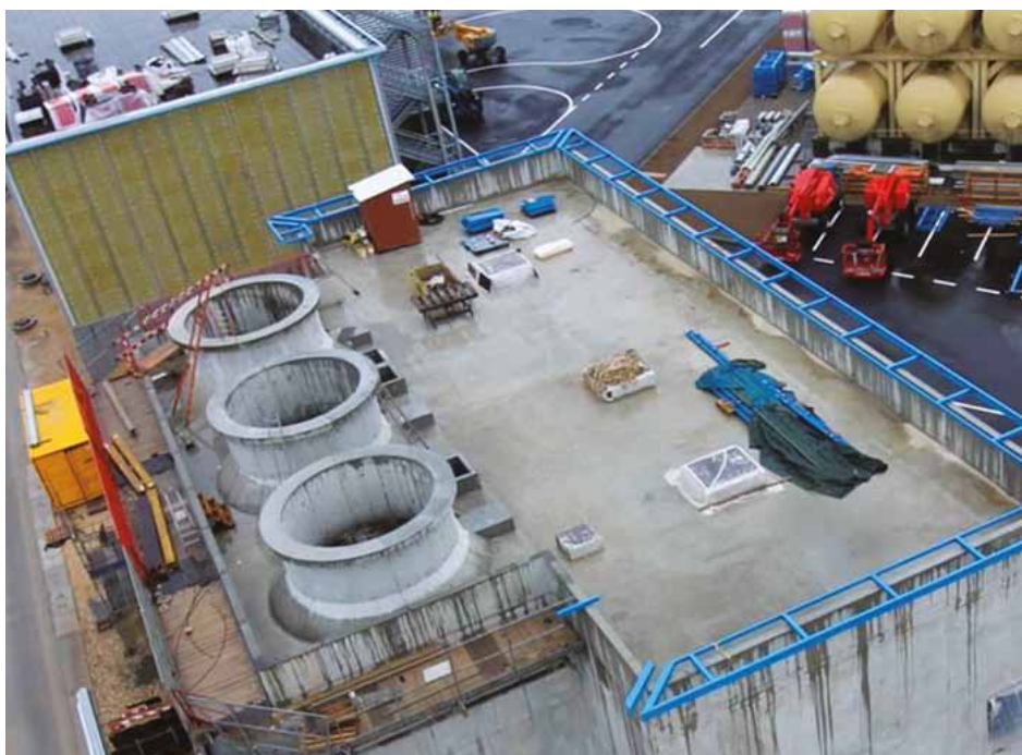
Rys.19 Zdjęcia kominów z zakończenia budowy
