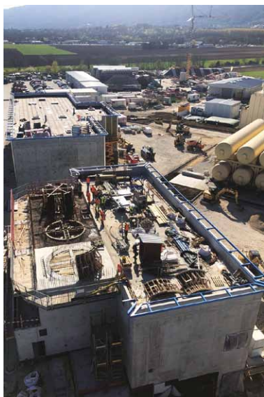
Rys.17 Budowa. Widoczny etap 1 i etap 2
