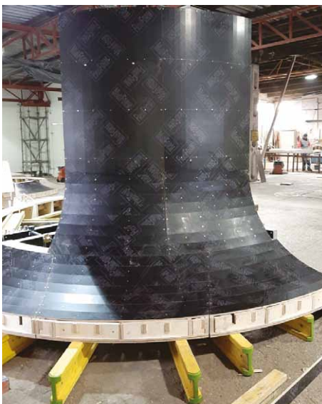
Rys.18 Widoczne fasetowanie powierzchni torusa. Faza pierwomontażu w hali Budosprzętu
