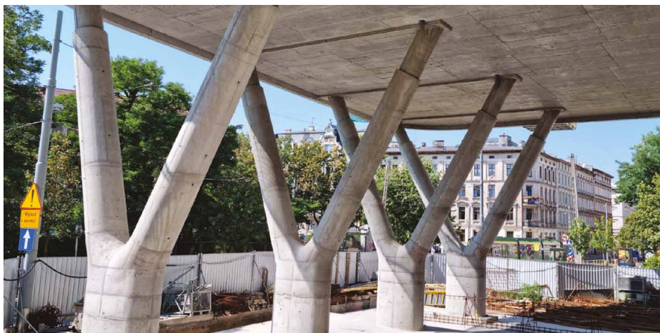
Rys.6 Słupy wspornika po zabetonowaniu
