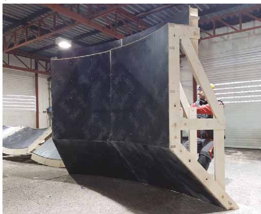
Rys.16 a) Test dopasowania form zewnętrznych etapu 2 b) Test dopasowania form wewnętrznych etapu 2
