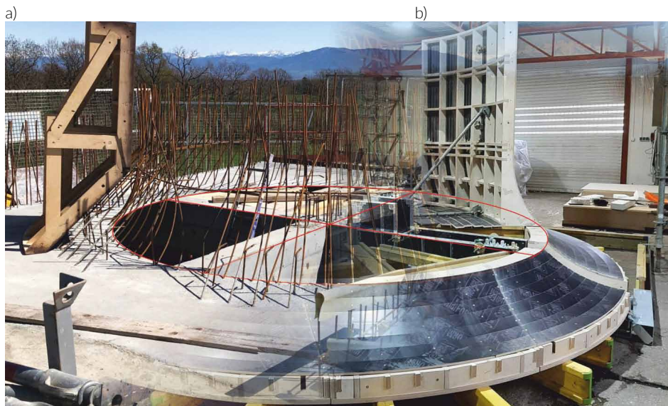
Rys.20 a) Budowa, b) Pierwomontaż na hali produkcyjnej
