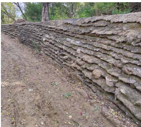
Fot. 10. Fragment muru Kopca Powstania Warszawskiego przy technologii S1
