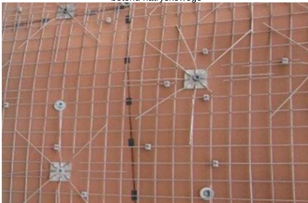
Fot.2 Sposób zawieszenia deskowania traconego i siatki stalowej z „pajączkami” i elementami dystansowymi
