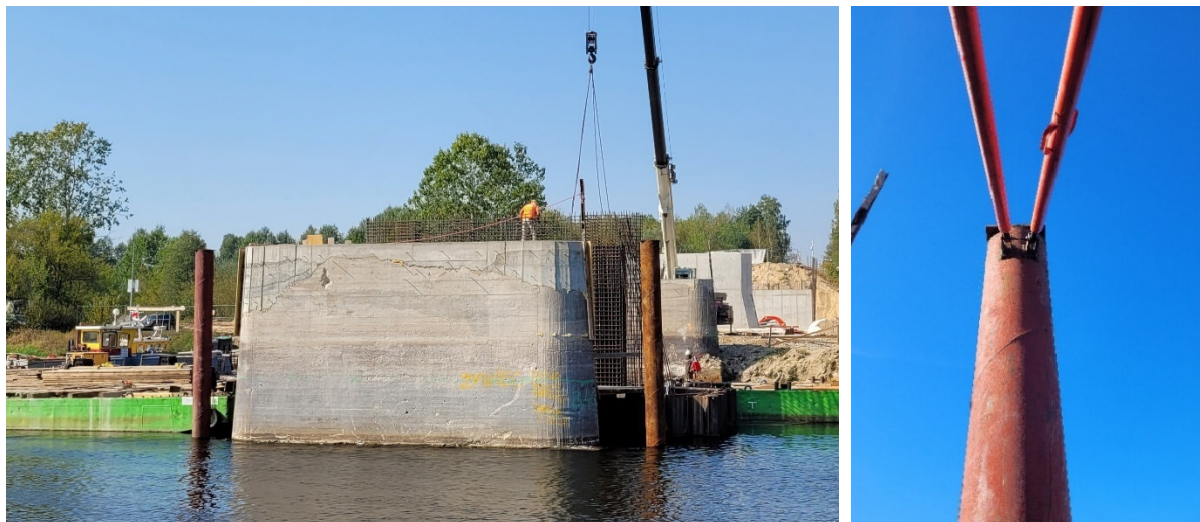
Fot.17. Podpora starego mostu skuta i wyrównana do poz +104,19 oraz słupopale zastabilizowane wyporami SLS.
