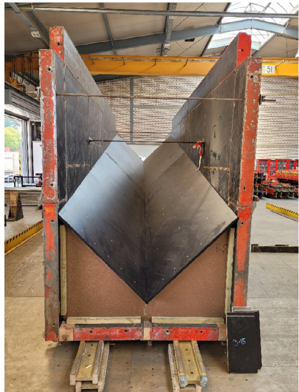
Fot.6. Forma izbicy filarów P3 i P4 oraz jej pierwomontaż na zakładzie PERI.
