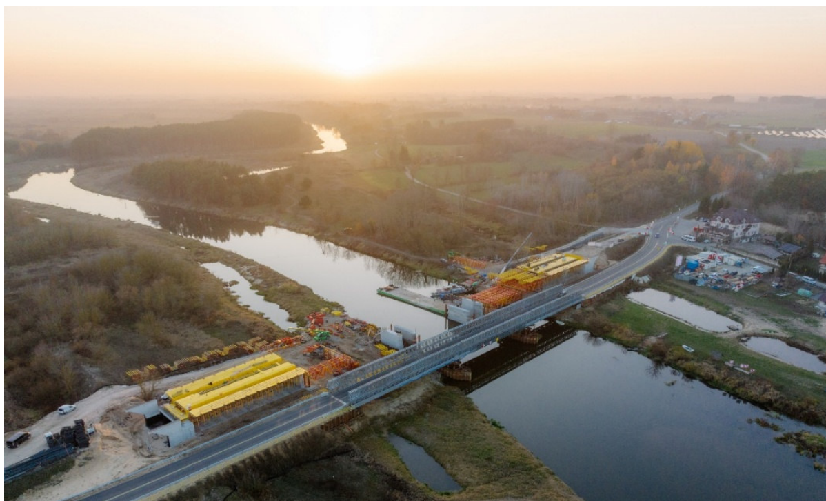
Fot.1. Realizacja mostu w Wiźnie przy użyciu konstrukcji podporowych PERI
