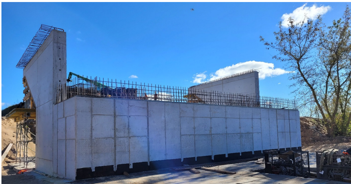
Fot.4. Deskowanie korpusu i skrzydeł w osi 6 z pomostem PERI UP Flex.
