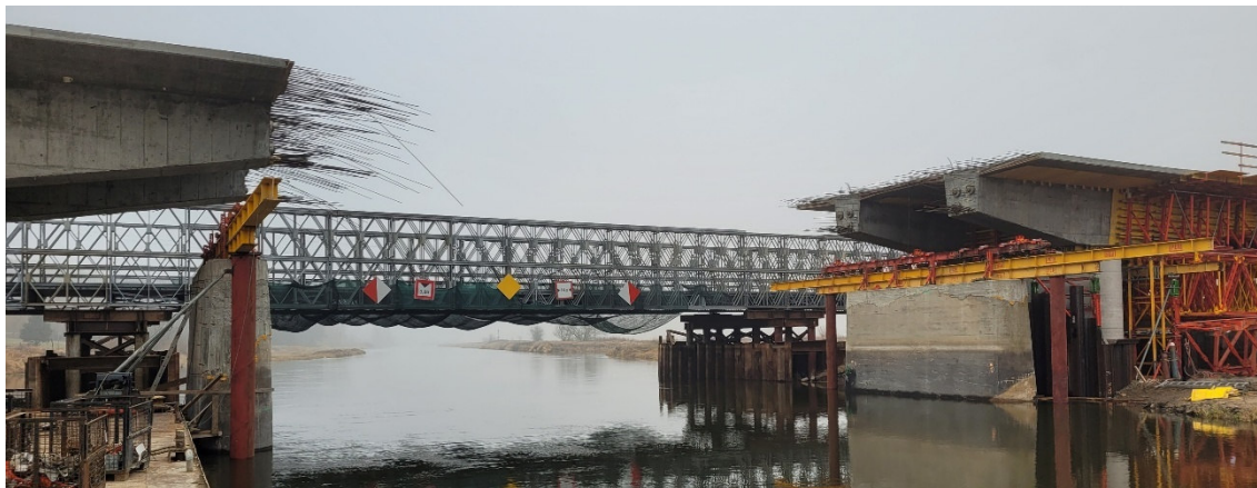
Fot.16. Podpory starego mostu w rozstawie osiowym 27,80m przygotowane do realizacji ostatniego fragmentu przęsła nurtowego L=26,0m
