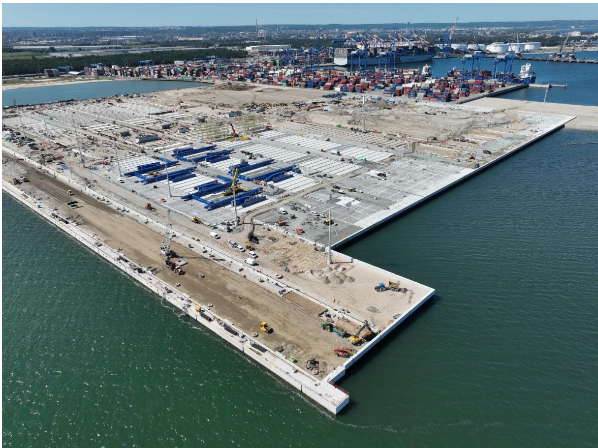
Zdjęcie 1. Widok nowopowstałego Terminala T3 Źródło: Budimex S.A.
