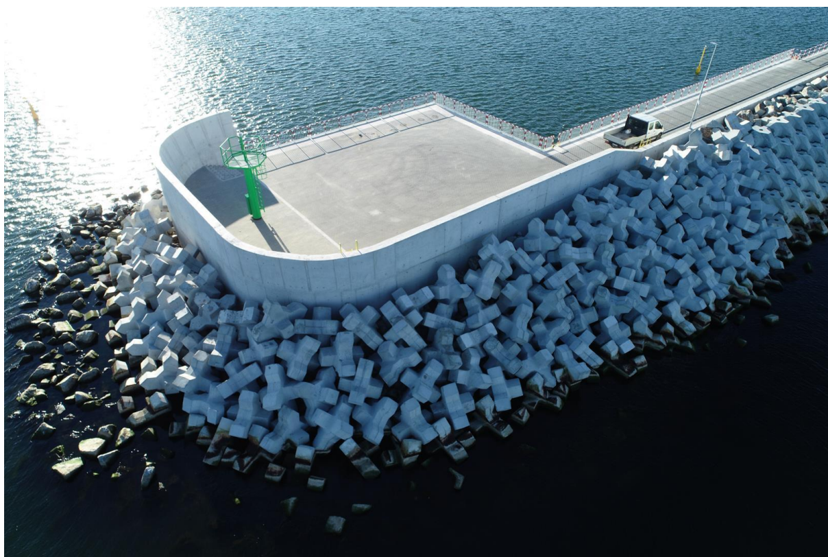
Zdjęcie 16: Głowica falochronu zachodniego
