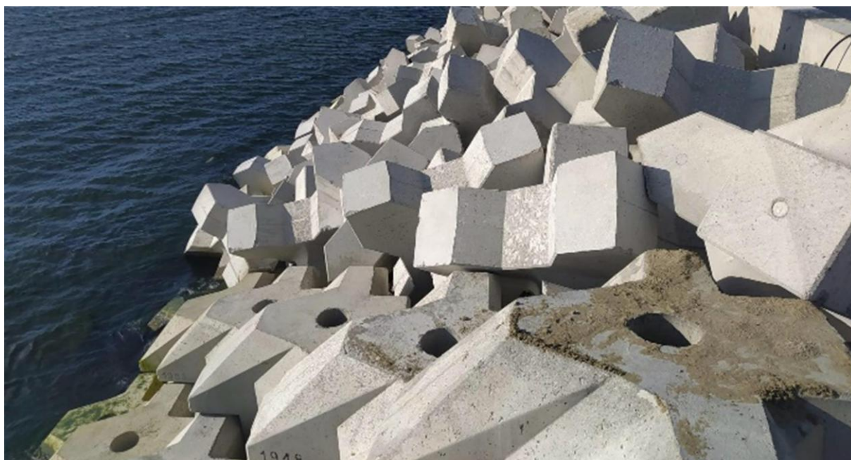
Zdjęcie 15: Przejście z XblocPlus na Xbloc
