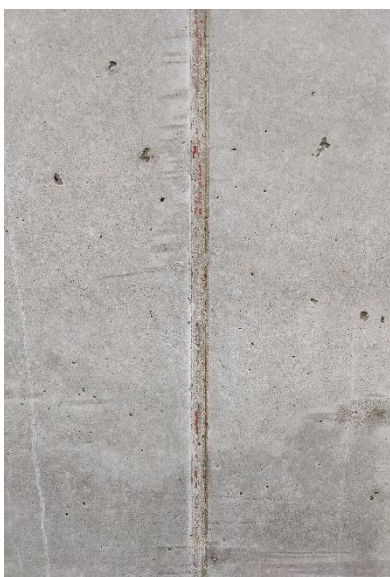
Fot. 9a. Zjawisko falsowania sklejk.
