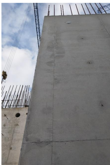
Fot. 9b. Zjawisko falsowania sklejk.
