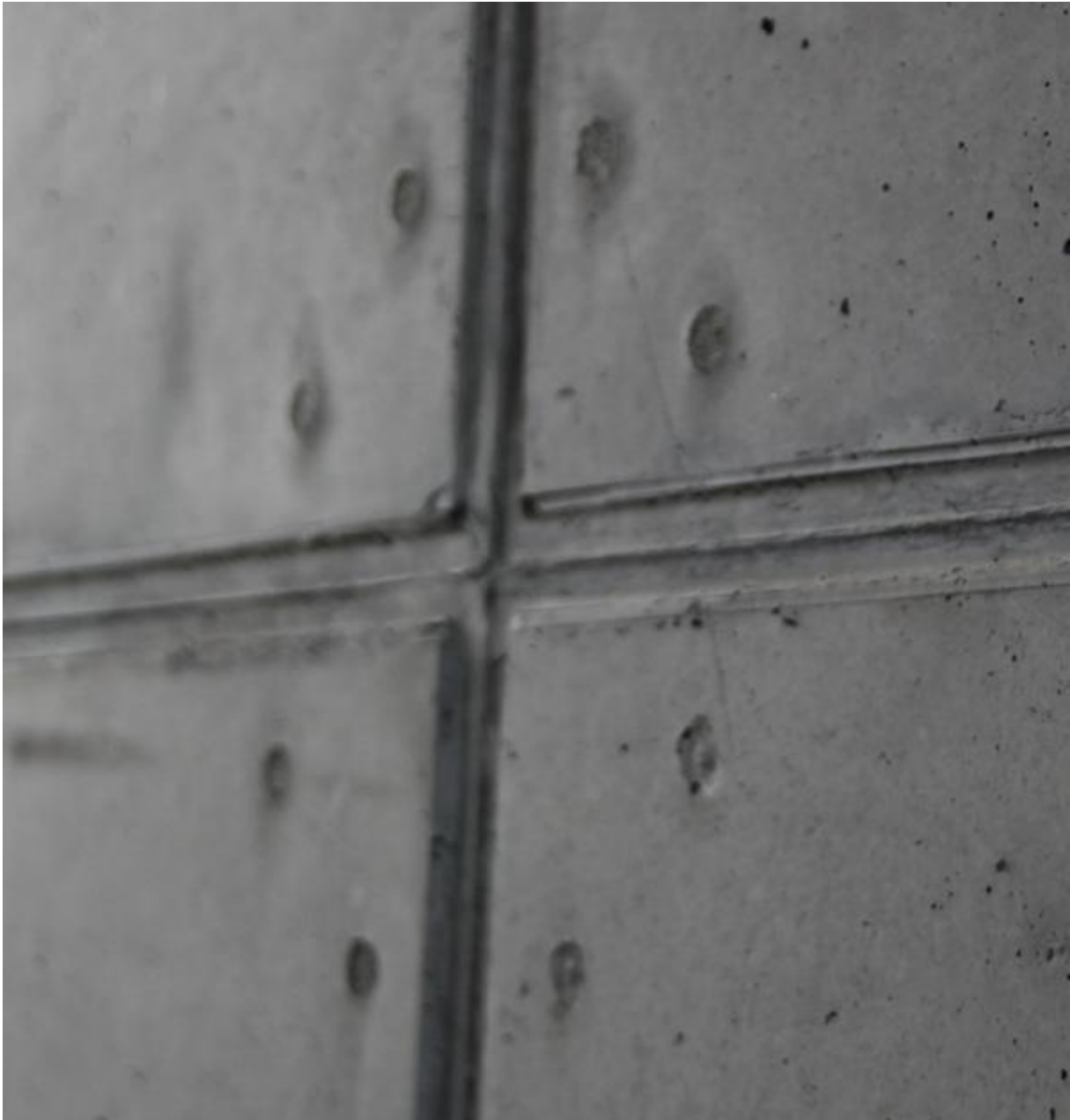
Fot. 8. Efekt gwoździowania sklejki – rippling
