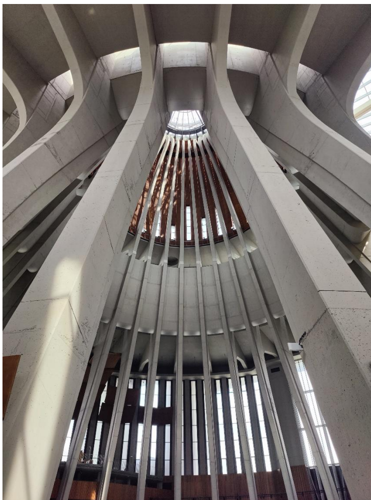
Fot. 14. Beton pokryty kolorową powłoką
