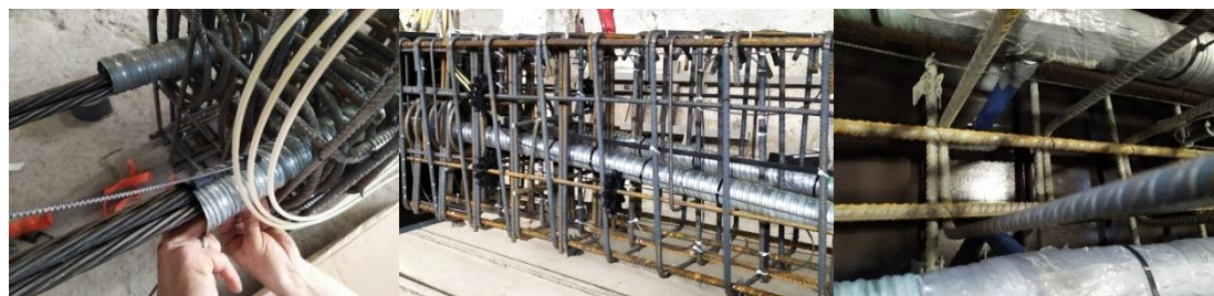
Fot. 2. Instalacja przykładowych czujników w belkach.
