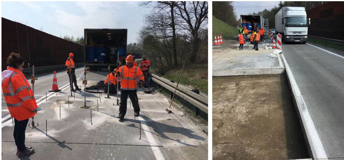
Rys. 7. Iniekcje geopolimerem pustek znajdujących się pod płytami betonowymi.
