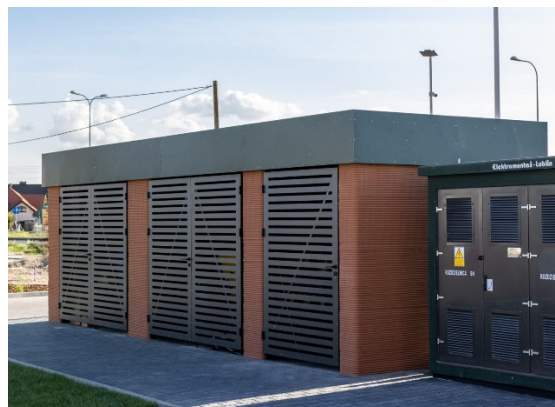
Rysunek 3. Pierwszy obiekt budowlany wykonany w technologii druku betonu 3D w Polsce, w trakcie wytwarzania in-situ (po lewej) oraz po ukończeniu (po prawej), © Rebuild sp. z o.o.
