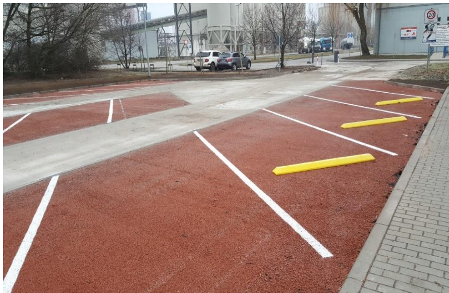
Fot.10. Parking z betonu PERVIA przy cementowni Cemex Rüdersdorf w Niemczech.
