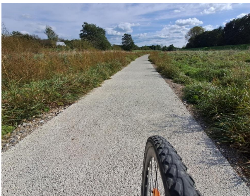
Fot.6. Realizacja ścieżki rowerowej przy rzece Rudawie w Krakowie.
