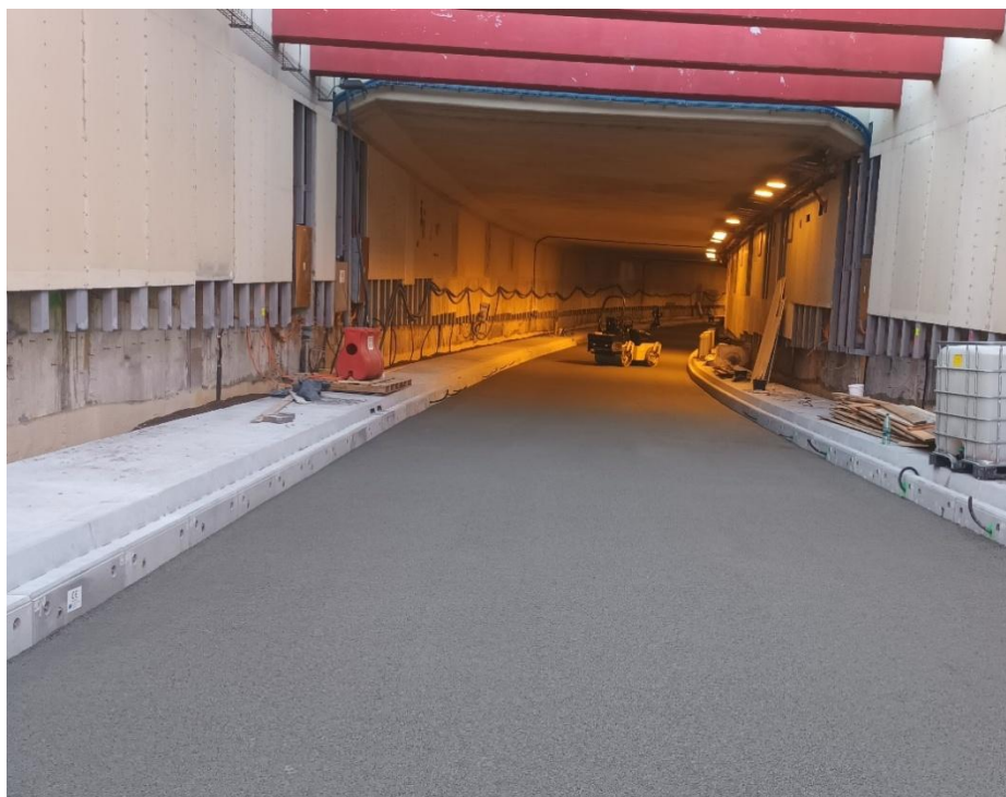
Fot.12. Gotowa podbudowa z PERVIA path w ciągu komunikacyjnym.
