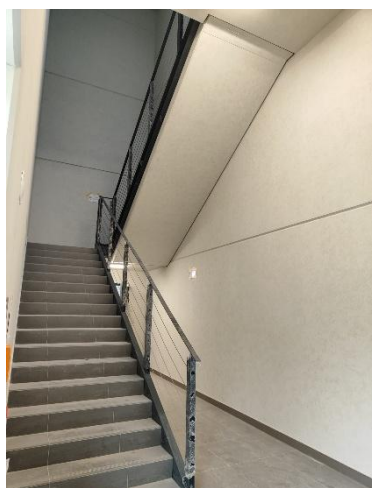
Fot. 13 Beton po Betonkosmetik BEKO Betondesign (M.Bryl)
