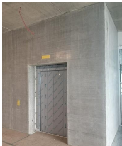
Fot. 4 Powierzchnia betonu przed Betonkosmetik, BEKO Betondesign (A.Huhn)
