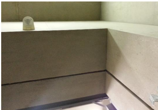
Fot. 6 Element przed Betonkosmetik, BEKO Betondesign (S. Wieczorek)
