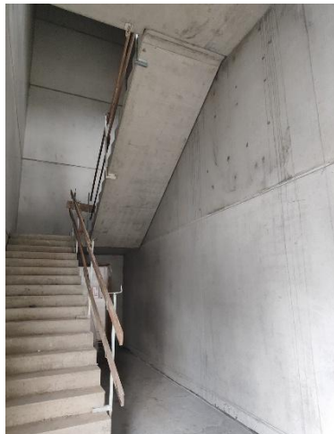
Fot. 12 Beton przed Betonkosmetik BEKO Betondesign (M.Bryl)
