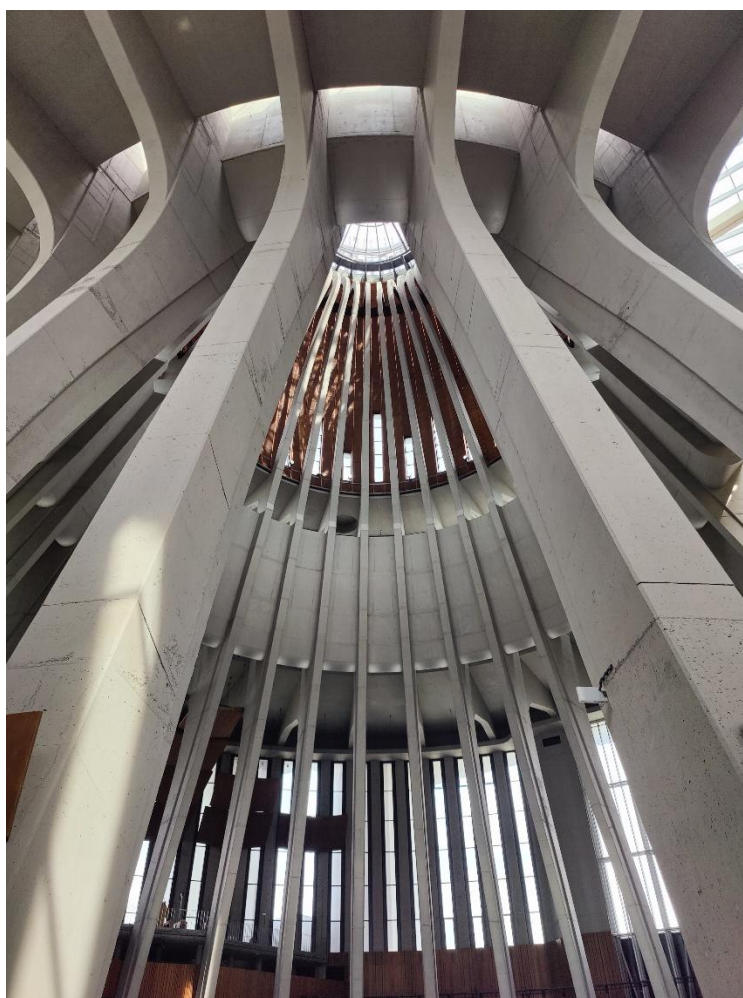
Fot. 14. Beton pokryty kolorową powłoką
