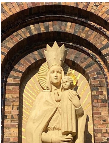
Fot. 15 Figura po renowacji BEKO Betondesign (A. Stawiszyńska)
