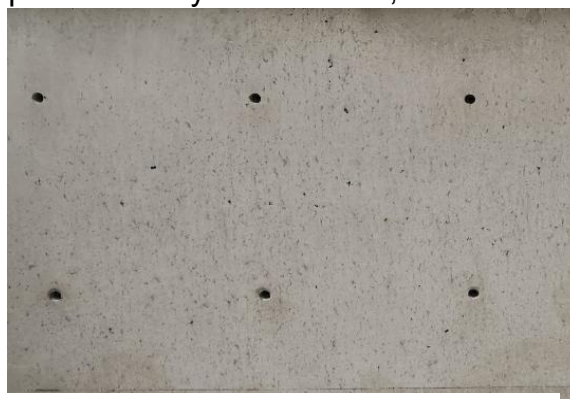
Fot. 1 Powierzchnia betonu przed Betonkosmetik, BEKO Betondesign (S. Wieczorek)
