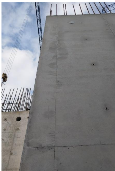
Fot. 9b. Zjawisko falewania sklejki.
