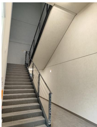
Fot. 13 Beton po Betonkosmetik BEKO Betondesign (M.Bryl)
