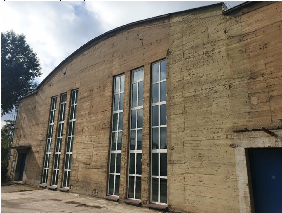
Fot.1. Elewacja szczytowa odżelaziacza. Ściana żelbetowa, wykonana w deskowaniu tradycyjnym, z wyraźnie odcisniętymi pojedynczymi deskami, ułożonymi równolegle do poziomu
