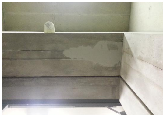
Fot. 7 Element po kosmetyce betonu, BEKO Betondesign (S. Wieczorek)
