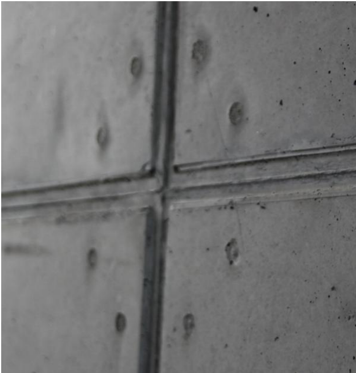
Fot. 8. Efekt gwoździowania sklejki – rippling
