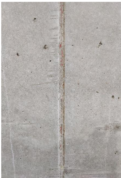
Fot. 9a. Zjawisko falewania sklejki.
