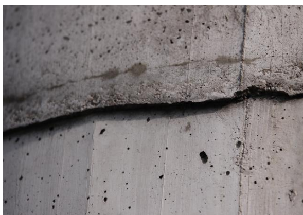
Fot. 6a. Przesunięcie płaszczyzny - połączenie pionowe
