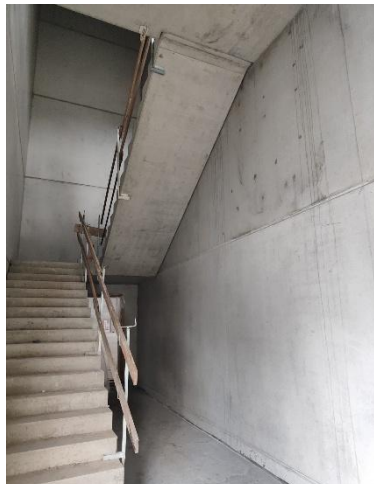
Fot. 12 Beton przed Betonkosmetik BEKO Betondesign (M.Bryl)
