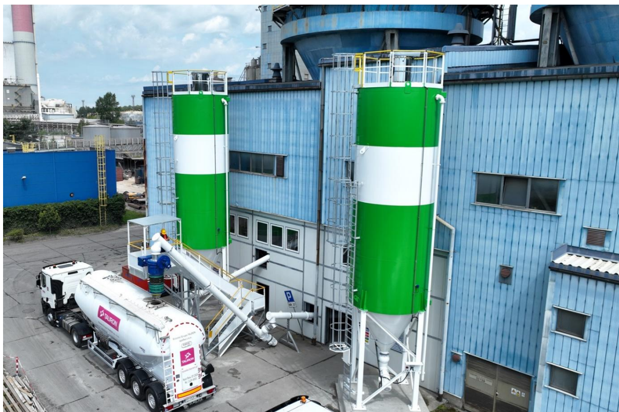
Rysunek 1. Instalacja do waloryzowania popiołów Bioeko Grupa TAURON
