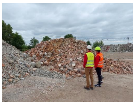
Rysunek3. Przykład selekcji odpadów budowlanych do produkcji kruszywa recyklingowego
