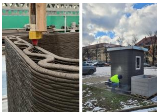
Rys. 2. Wykonywanie prac pomiarowych przy pomocy georadaru (po lewej) oraz przygotowanie ściany do badania sklerometrem (po prawej).
