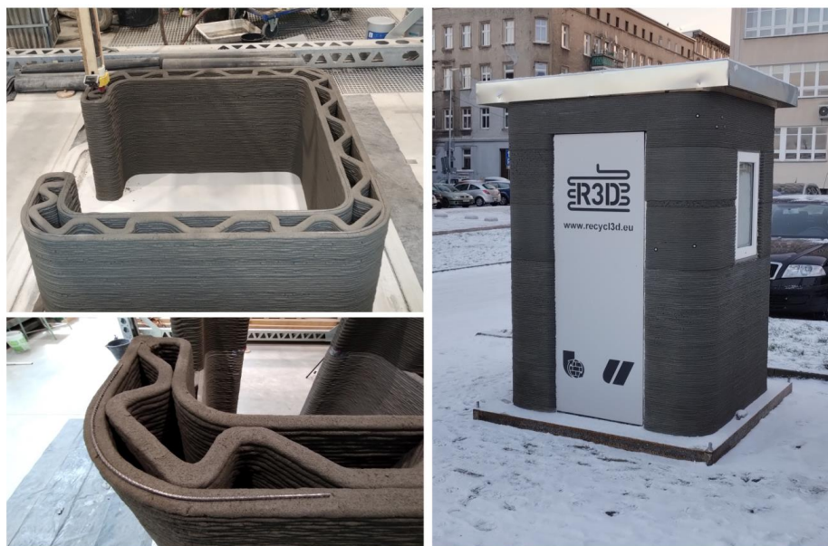
Rys. 1. Wydruk wielkoformatowy – z lewej: ściana w czasie druku, z prawej: wydrukowany obiekt demonstracyjny
