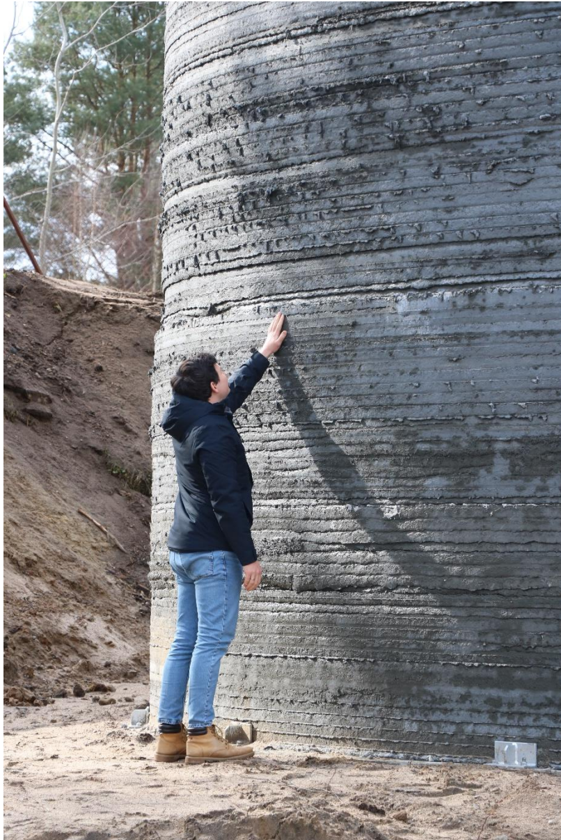
Rysunek 6. Zbliżenie na warstwowy układ betonu na ścianach
