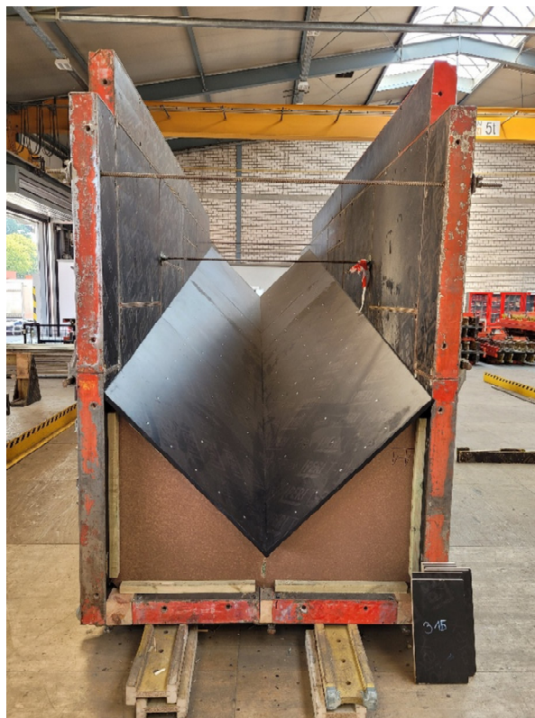
Fot.6. Forma izbicy filarów P3 i P4 oraz jej pierwomontaż na zakładzie PERI.
