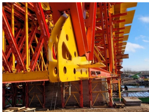
Fot.15. Odcigi DW15 i podwaliny oraz ugięcie kratownic L=14,375 po betonowaniu.
