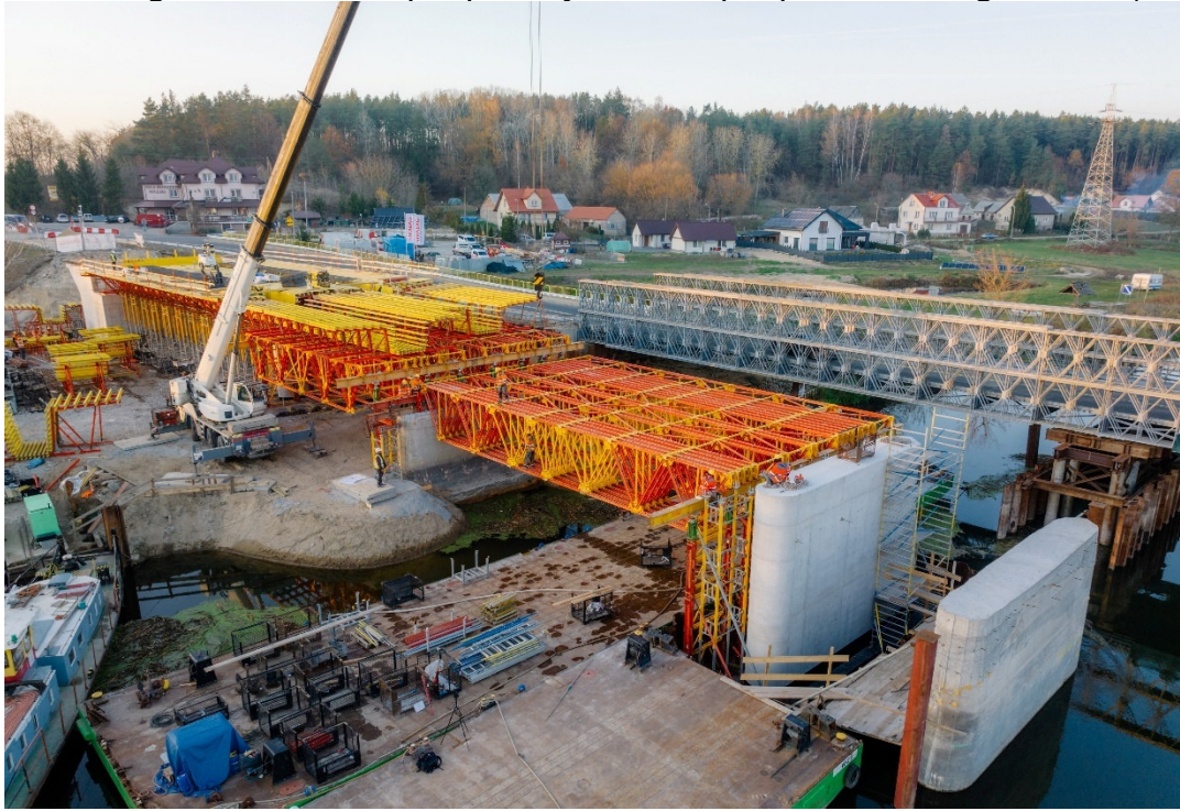
Fot.13. Przęsło nr 2 z zamontowanymi kratownicami L=14,375\text{m} i podczas montażu kratownic L= 19,125\text{m} na tarczy VST i podporze starego mostu.
