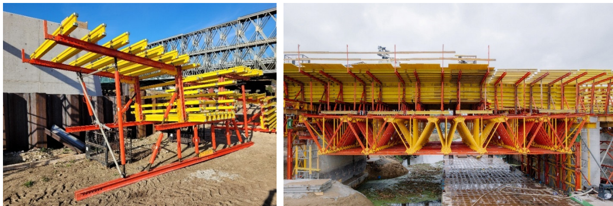
Fot.14. Krążyna VARIO w obszarze kratownic L=19,125\text{m} i widok z boku na pogrubienie belek w obszarze podpory nurtowej nr 3.
