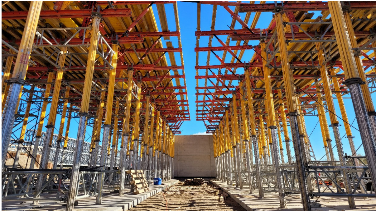
Fot.9. Rusztowanie podporowe MULTIPROP, krążyny VARIO, odciąg skośne DW15 i nabijanie sklejki poszyciowej 3S (z prawej strony) - na przęśle nr 1, w osiach 1-2.
