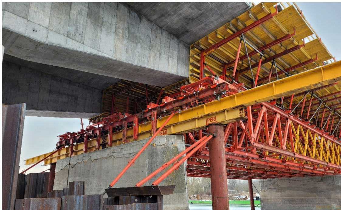
Fot.22. Widok na belki transferowe 2xHEB400, kliny odciążające HD i łożyska toczne.
