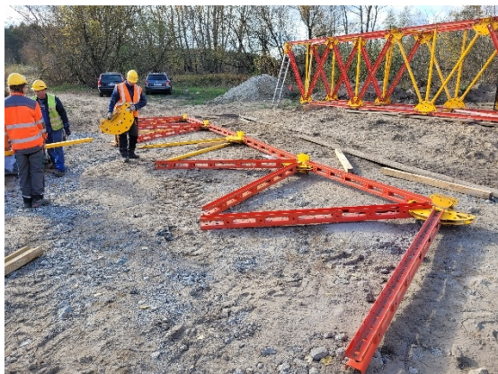
Fot.10. Ręczny montaż na budowie oraz połączenia przy użyciu sworzni pasowanych.
