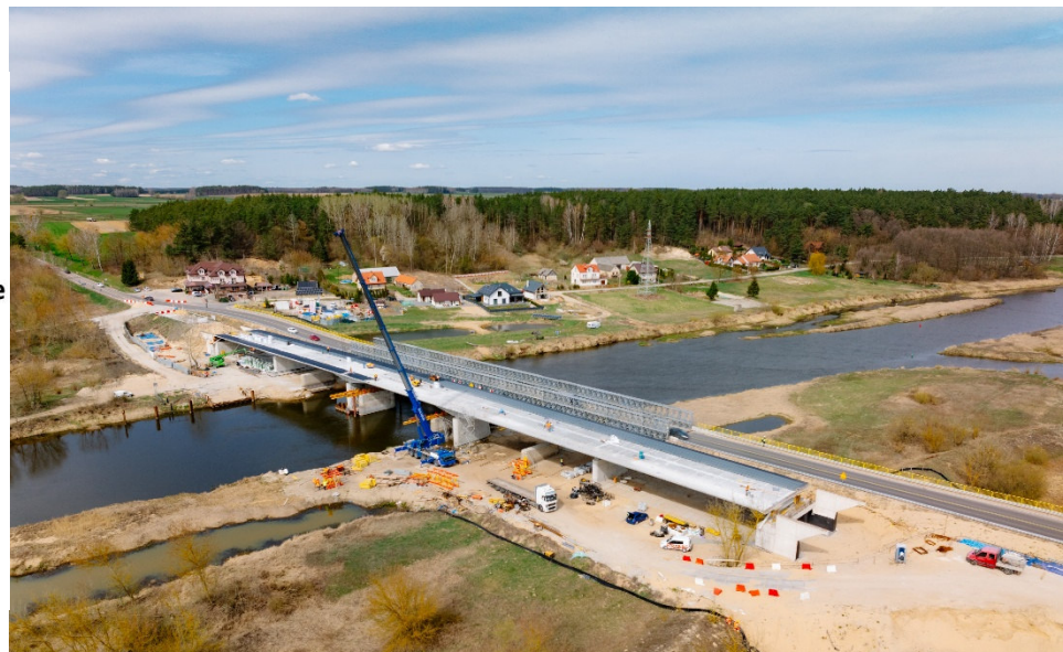
Fot.24. Widok na most w Wiźnie nad Narwią.
