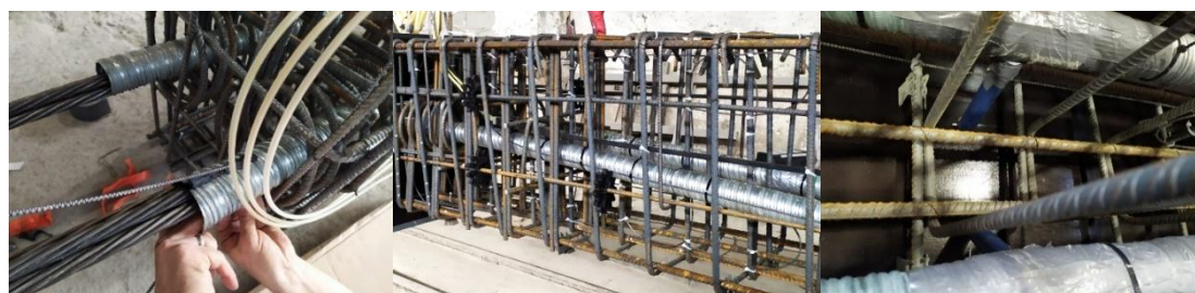
Fot. 2. Instalacja przykładowych czujników w belkach.
