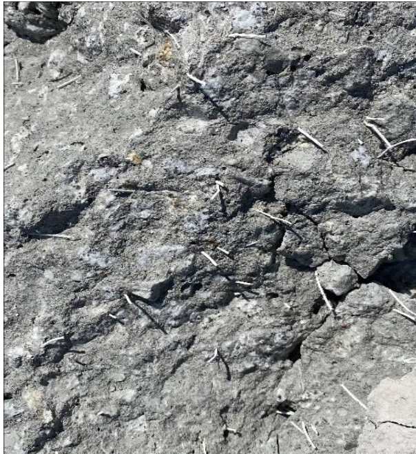
Rys. 2. Włókna w betonie.
