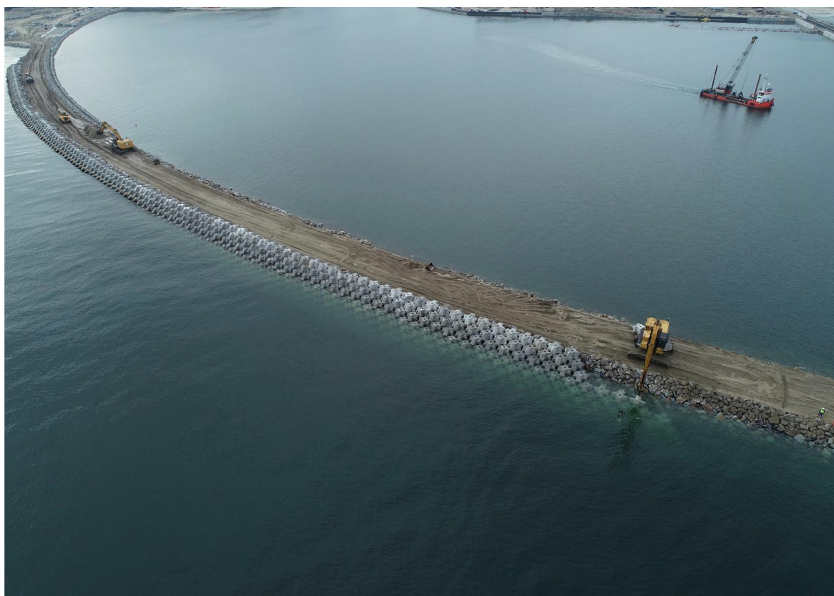
Zdjęcie 10: Budowa falochronu wschodniego
