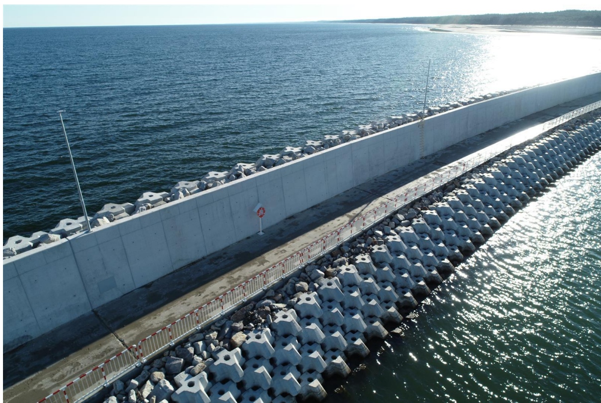
Zdjęcie 11: Budowa falochronu wschodniego
