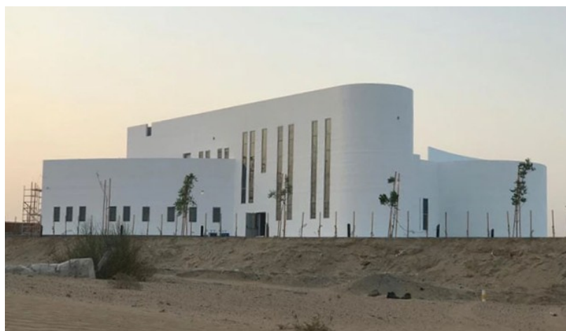
Rysunek 4. Dwupiętrowy budynek biurowy w Dubaju wydrukowany przez Apis Cor w 2019; z lewej widoczne kosze zbrojeniowe kolumn wsunięte w kieszenie i gotowe do zalania betonem; © Apis Cor
