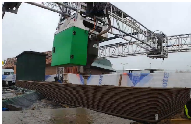
Rysunek 3. Pierwszy obiekt budowlany wykonany w technologii druku betonu 3D w Polsce, w trakcie wytwarzania in-situ (po lewej) oraz po ukończeniu (po prawej), © Rebuild sp. z o.o.
