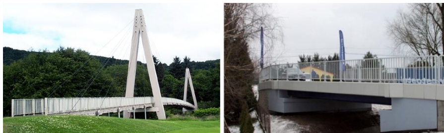
Rys. 2. Mostowe obiekty kompozytowe: a) kładka Aberfeldy Footbridge w Wielkiej Brytanii oraz b) most kompozytowy w Nowej Wsi k/Rzeszowa [12, 13]
